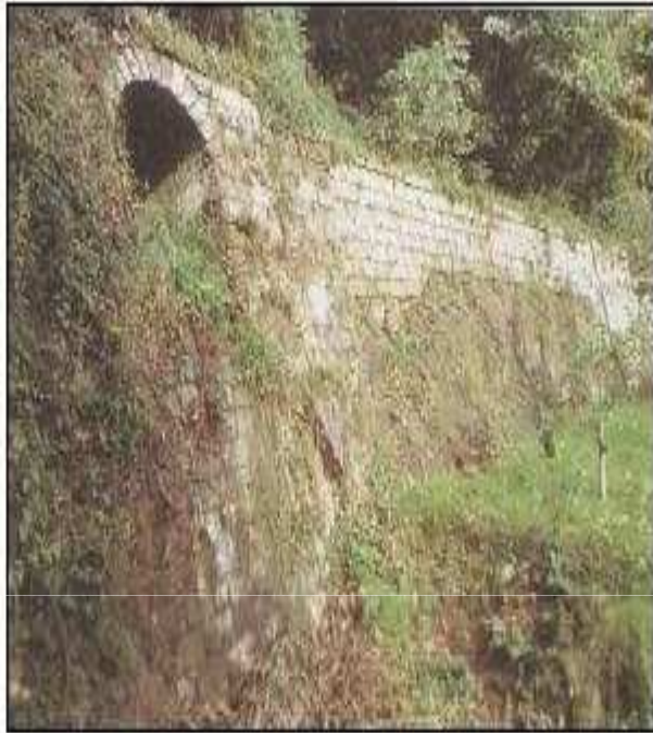
Canale artefatto (palata) che convogliava le acque alla torre del mulino dell'Infernata.
